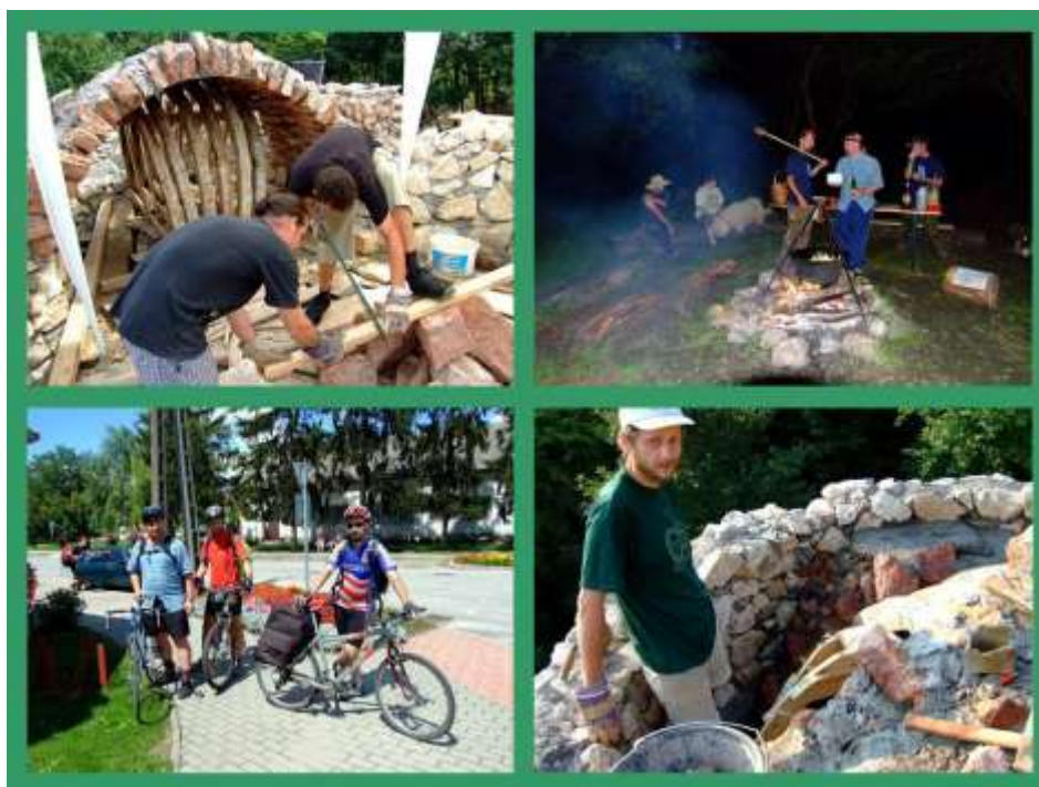
6. ábra. Életképek az ökotáborból; (bal felső) Az apszis boltozatának készítése. (jobb felső) Munka után bográcsban készül az egytálétel. (bal alsó) Az építők egy csoportja kerékpárral a Budapesttől 80 km-re lévő ökotáborba tart. (jobb alsó) Az apszis boltozata és a térdfal közé kitöltő falazat kerül. Előtte onnan történik a fal rakása.
