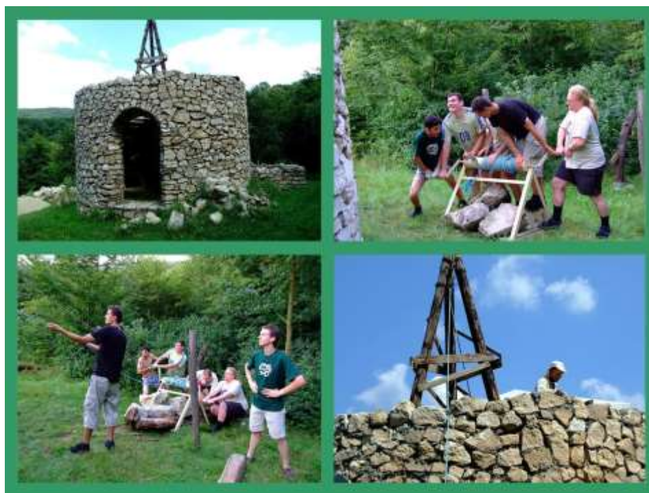
5. ábra. Életképek az ökotáborból; (bal felső és jobb alsó) A felhúzott köveket fogadó háromlábú állványzat. (jobb felső és bal alsó) A sokszor két-háromszáz kilós kövek felhúzása még csörlővel is embert-próbáló feladat
