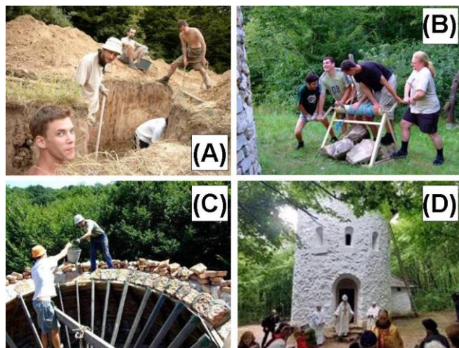
5. ábra: Az ökotábor-sorozat során épülő rekonstrukció négy jellemző állomása: (A) a kezdet, az alapárok kiásása; (B) életkép a falépítés folyamatáról; (C) a boltozat építése; ((D) a kész templom ünnepélyes megáldása
