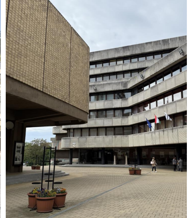
A Városháza épületei Nyíregyházán és Salgótarjánban Kép forrása: nyiregyhaza.hu; saját felvétel
