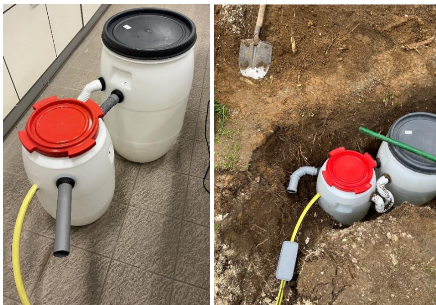
10. ábra: Az elkészült egyszerű vízmérő műtárgy
